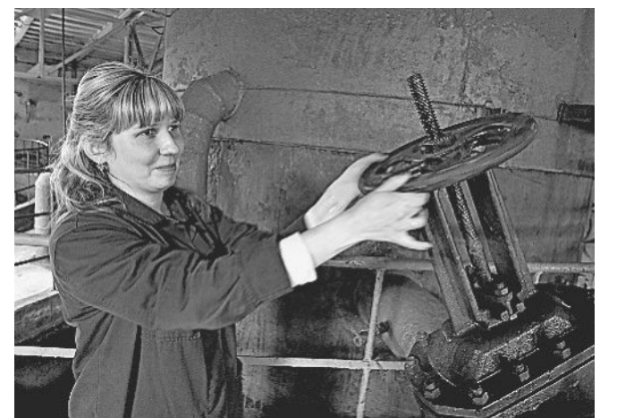
Оператор на фильтрах Юлия Сидорина управляет подачей воды на отстойник.
