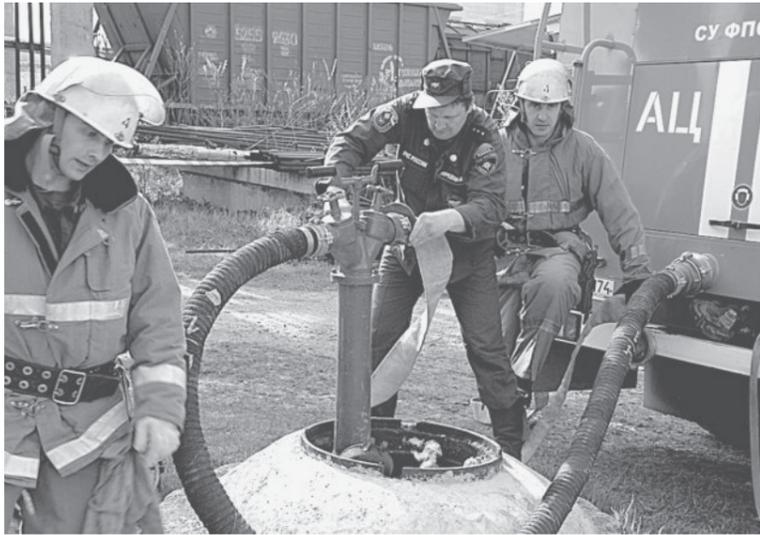
отводу поступающих в обваловку резервуаров грунтовых вод. Одновременно начаты инженерные работы по укреплению разрушающегося фундамента резервуара мазутохранилища ТЭЦ.
